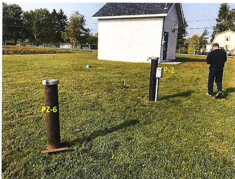
Vue du puits P-2 et du puits d'observation PZ-6 (Sept 2017)
