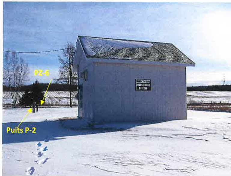
Vue de la station de pompage du secteur du puits P-2 (Déc 2019)
