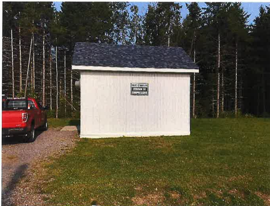
Vue de la station de pompage du secteur #1 Drain (Sept. 2017)
